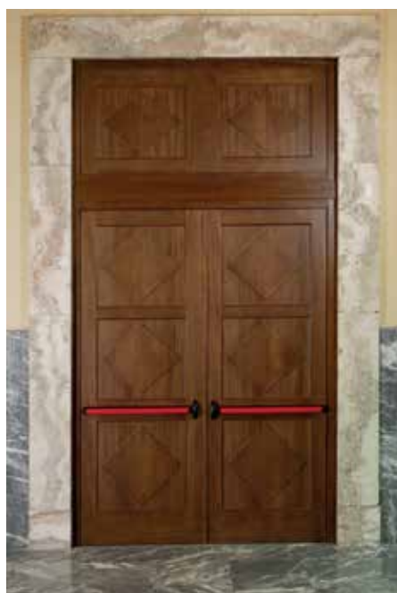
Realizzazione porta tagliafuoco in legno di Sebino Chiusure
